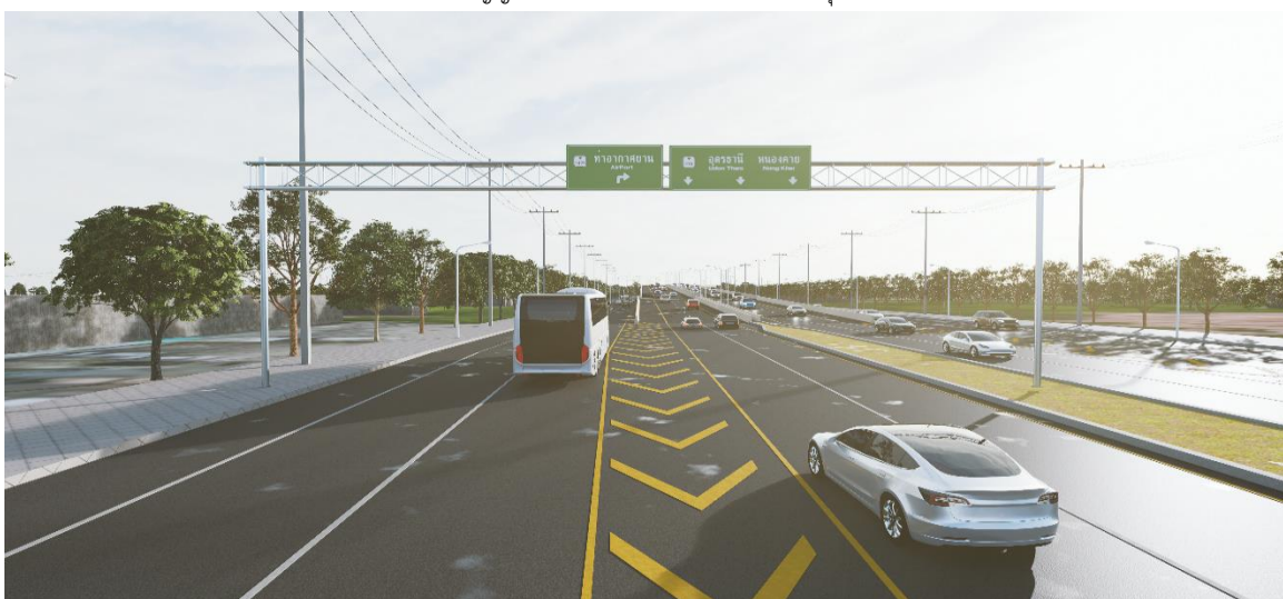
บริเวณสะพานข้ามทางเข้าสนามบินอุดรธานี
